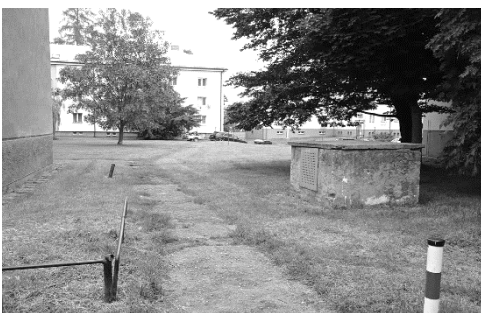
[3] Zděné pilíře filtroventilace krytu CO
