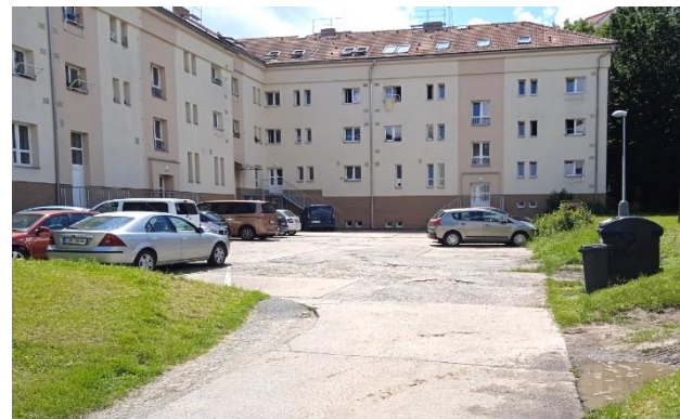
[4] obslužný dvůr využívaný k parkování vozidel; dosluhující cementobetonový kryt s poruchami krytu různého typu a rozsahu
